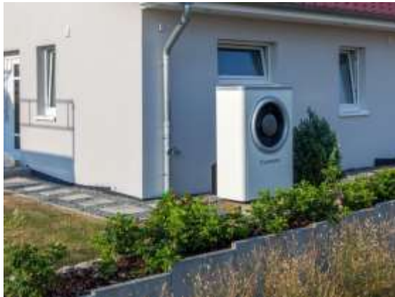
Luftwärmepumpe im Vorgarten
