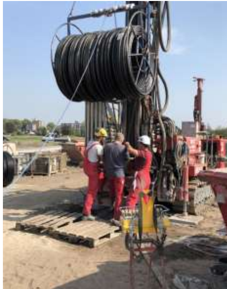
Tiefenbohrung und Sondenanschluss
