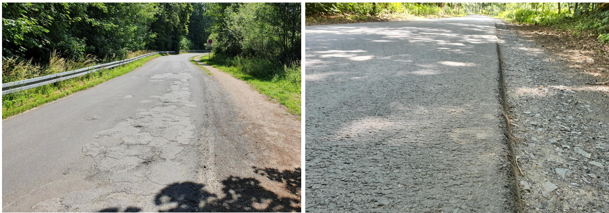
Abbildung 90: Fahrbahnschäden (links) und abfallende Randbereiche Streinen Esch - Velsen (Fotos: IPW))
