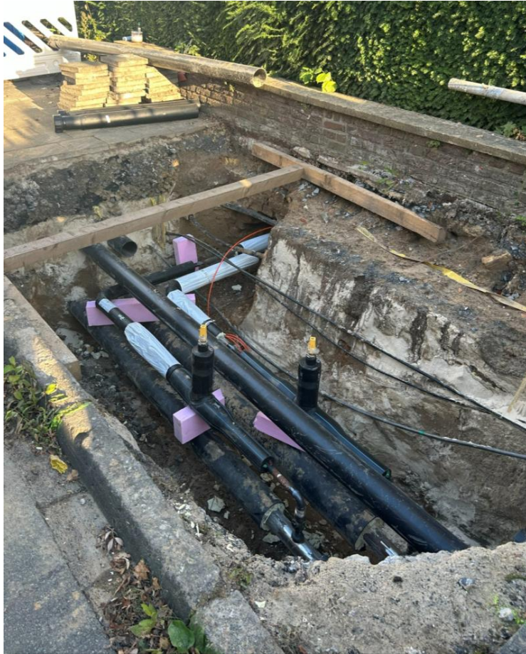
Fernwärmeausbau Münster. Eigene Aufnahmen 2025
