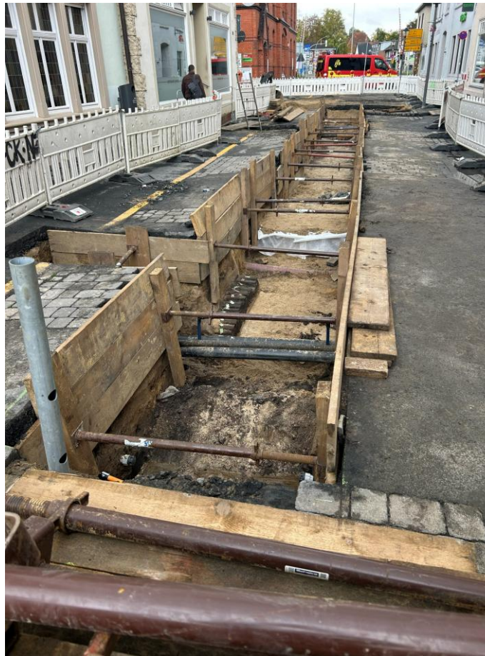
Baustelle Nahwärme Innenstadt Warendorf. Eigene Aufnahmen 2025
