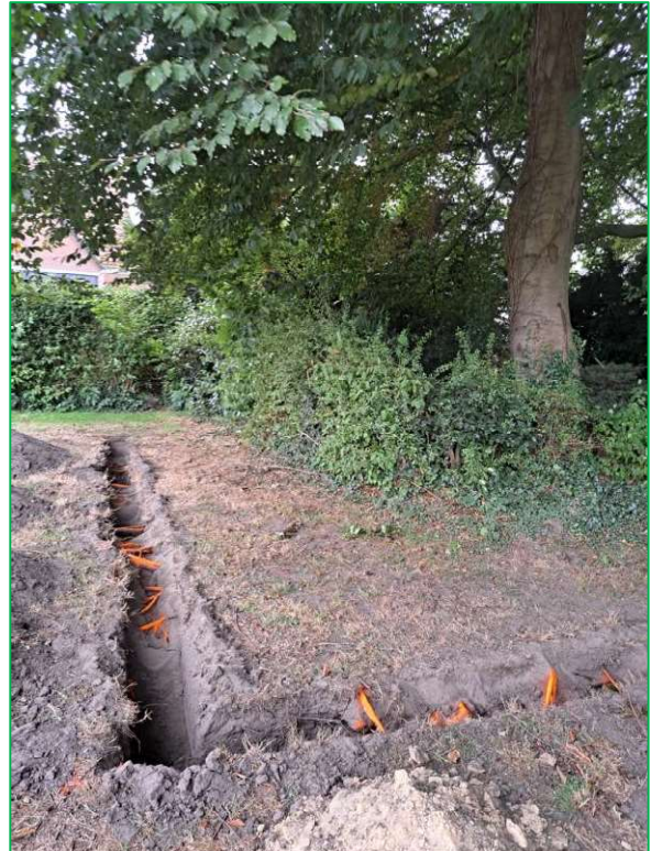
Abbildung 36: Suchgraben östlich des Baumes.
