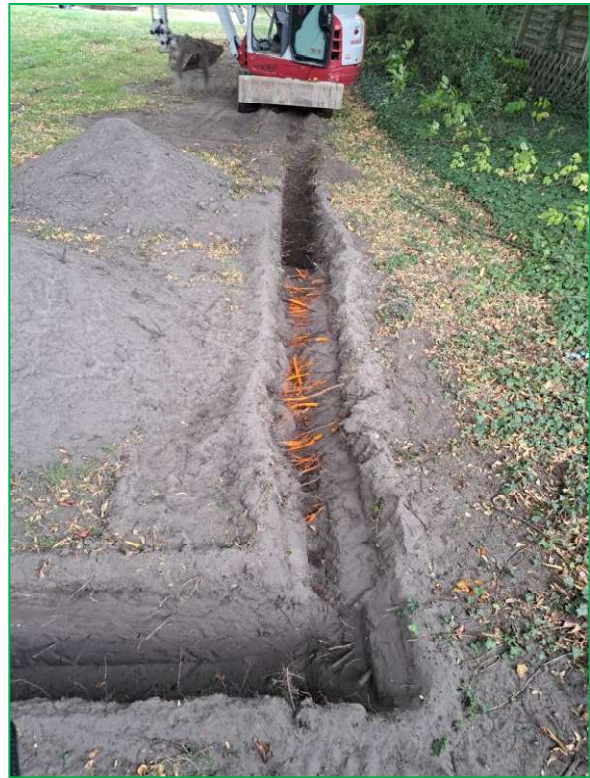
Abbildung 20: Suchgraben südlich des Baumes.
