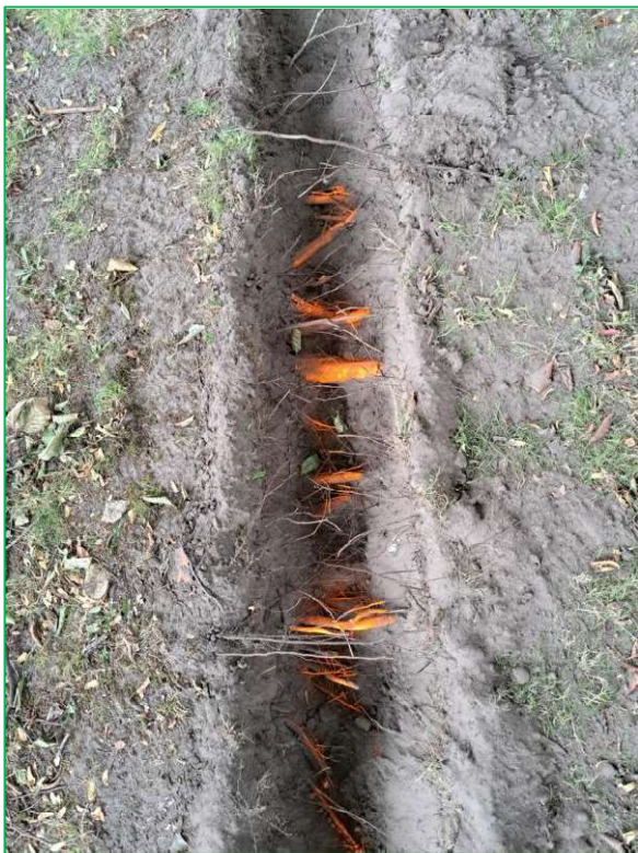
Abbildung 26: Wurzelteppich auf einer Länge von 3,5 m.
