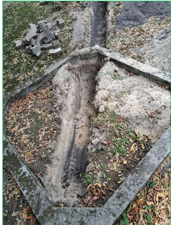
Abbildung 65: Suchgraben östlich des Baumes in 3 m Entfernung.
