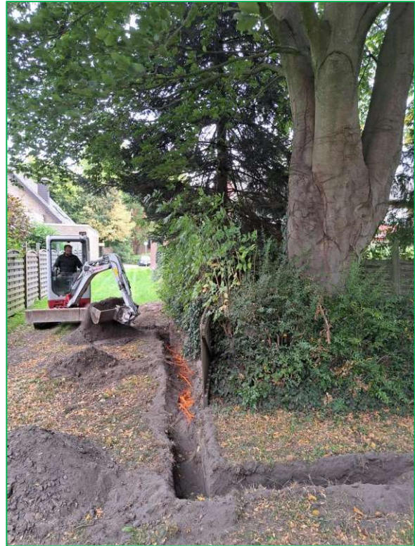
Abbildung 10: Suchgraben westlich des Baumes.
