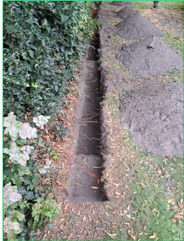
Abbildung 5: Wurzelsuchgraben von 5 m Länge.
