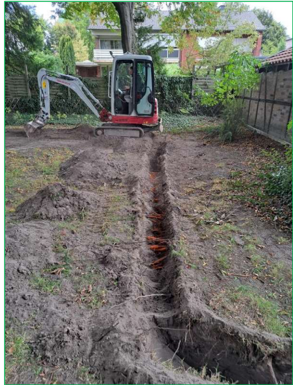
Abbildung 25: Suchgraben westlich des Baumes.
