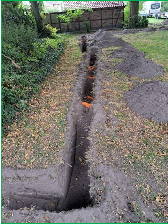
Abbildung 13: Suchgraben südlich des Baumes.
