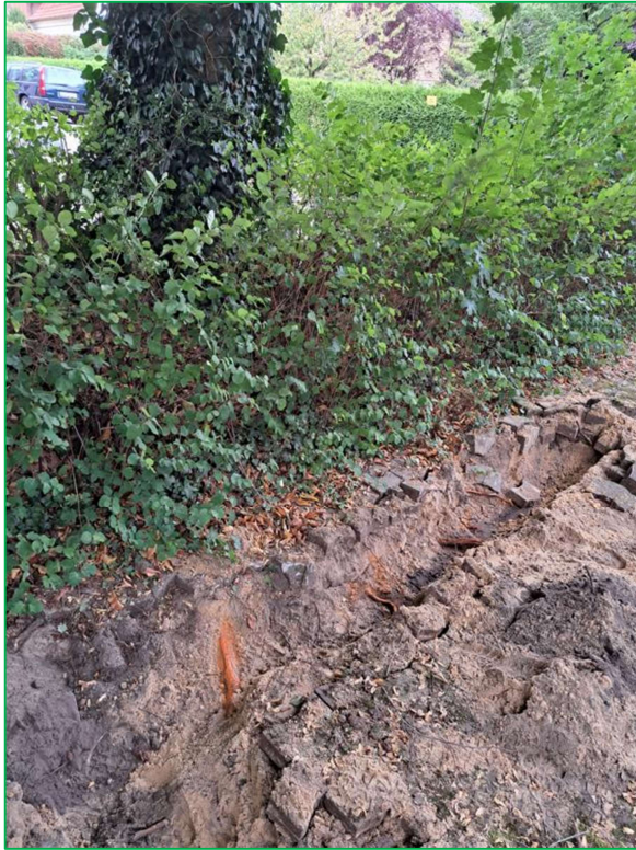
Abbildung 68: Suchgraben östlich des Baumes in 1 m Entfernung.
