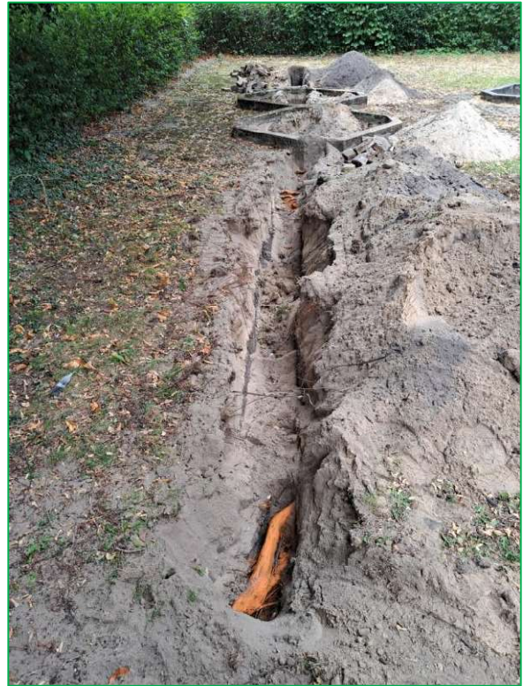
Abbildung 56: Wurzelsuchgraben östlich des Baumes, Graben geht in nächsten über.
