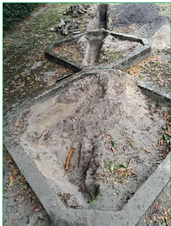
Abbildung 62: Suchgraben östlich des Baumes.
