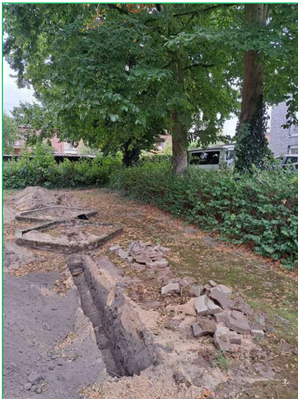
Abbildung 66: Suchgraben östlich des Baumes in 3 m Entfernung.
