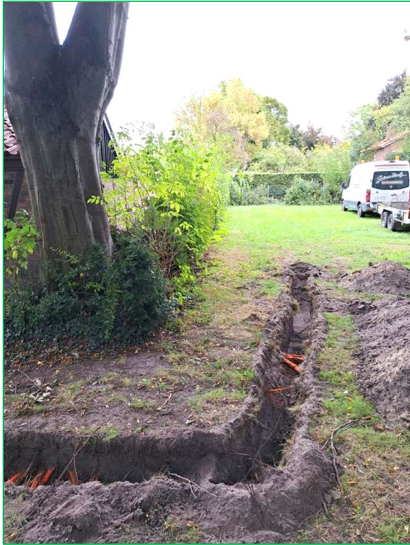
Abbildung 28: Suchgraben südlich des Baumes.
