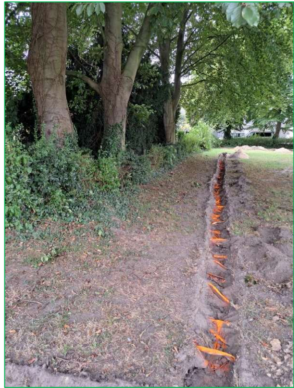
Abbildung 40: Suchgraben nördlich des Baumes, geht in nächsten Suchgraben über.
